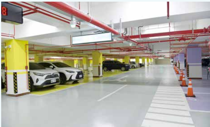
鹿港鎮洛津國小操場設置地下停車場兼蓄洪池。（彰化縣政府提供）
