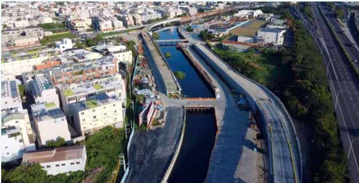
彰化大埔截水溝堤岸道路拓寬工程施工現況空拍。（資料來源：彰化縣政府）
